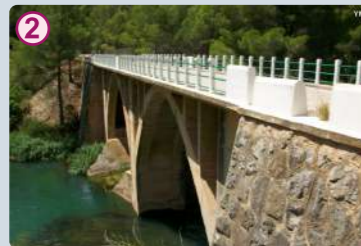
Puente cerca Pantano de Loriguilla
